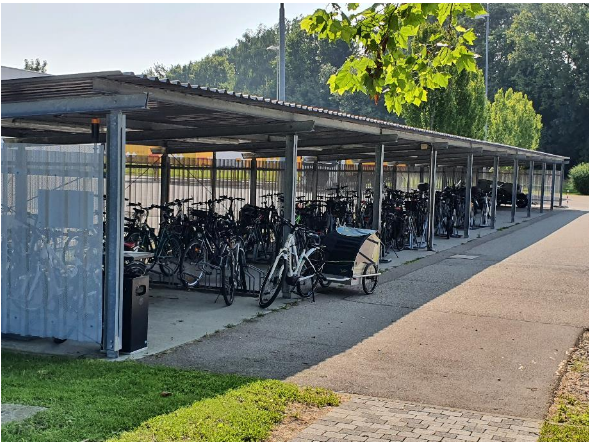
Der überdachte und beleuchtete Fahrradparkplatz wird von den Mitarbeitenden des Versandhaus Walz gerne genutzt.
